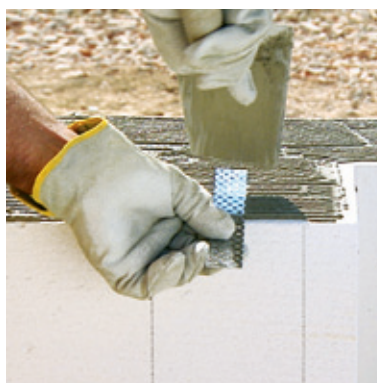
Spojka zdiva aplikovaná při stavbě nosné konstrukce.
